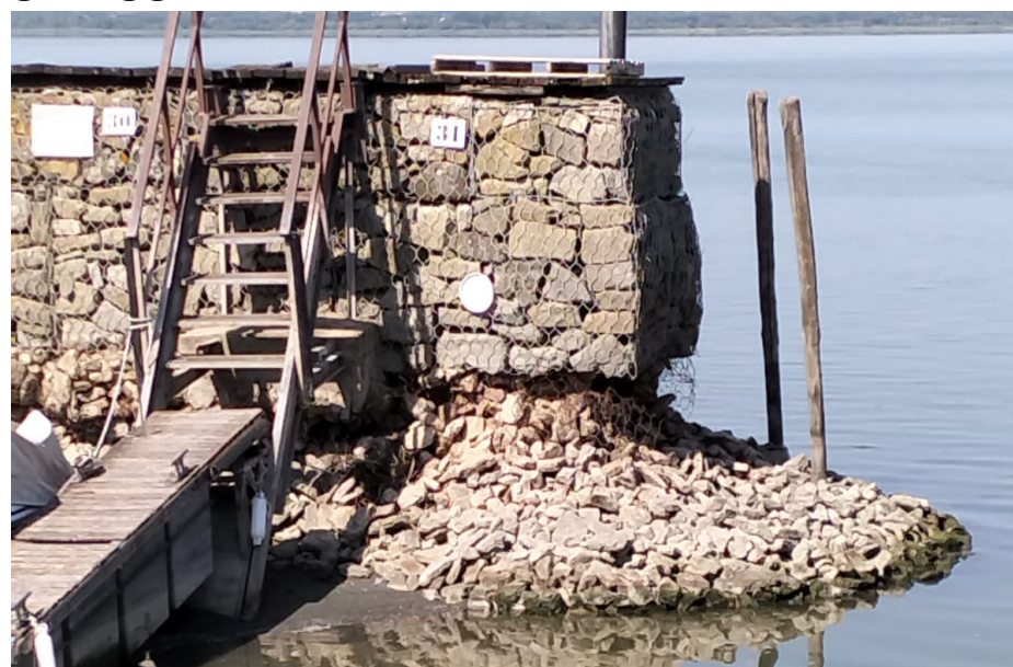
Stato dei gabbioni e delle fondamenta di appoggio
