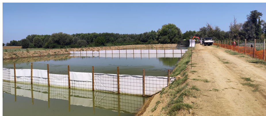
Vasca di decantazione in prossimità del Centro Ittiogenico
